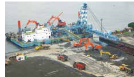
落下混合工法
